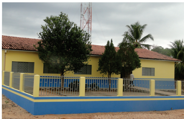
Com conclusão das obras de reforma e ampliação, a creche passa a dispor de melhores condições para receber as crianças
