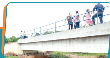
Pag. 04 - CESTE inaugura ponte de concreto em Babaçulândia/TO
