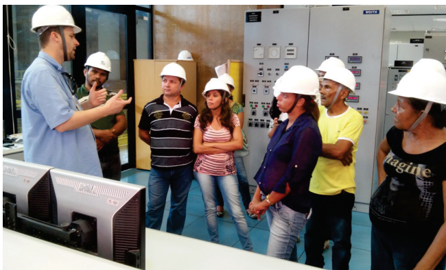
Agricultores conheceram as várias instalações da Usina Hidrelétrica Estreito, como a Sala de Operações
